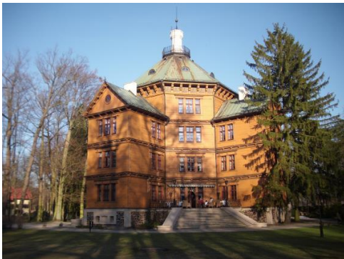
Jagdschloss in Antonin, aus Lärche gebaut
